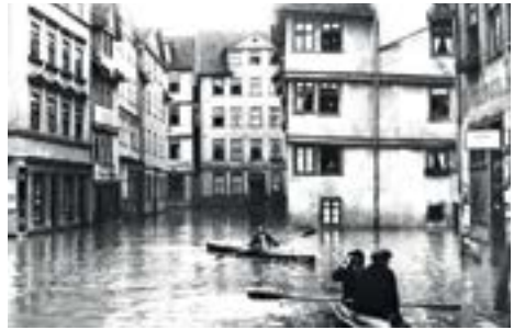
Hochwasser 1924 zu 1925 Holzmarkt zur Bettenhäuser Straße
