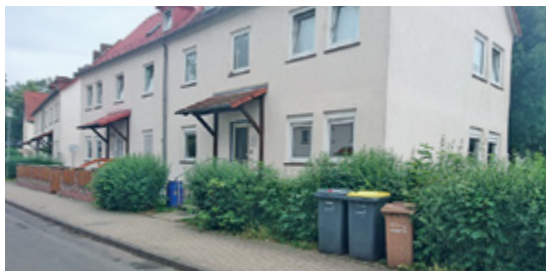
Das Stadtteilbüro in der Steinigkstraße 66.
