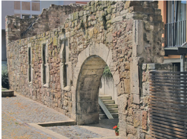
Ein Mauerrest der Unterneustädter Mühle an der Mühlengasse.
