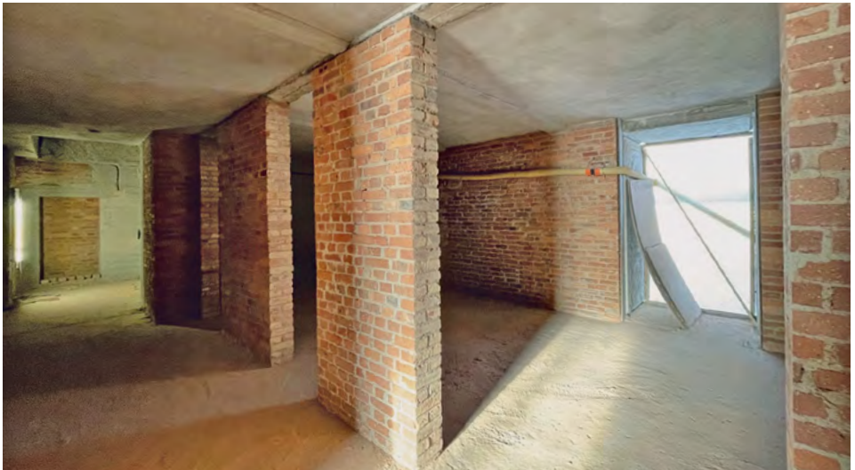
Vorhandene Ziegel aus dem Bunker werden wiederverwendet
