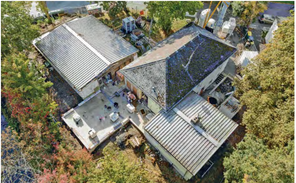
Im Luftbild ist der neue Küchenanbau am Geschwister-Scholl-Haus schon gut zu erkennen. Foto: Nicolai Benner
