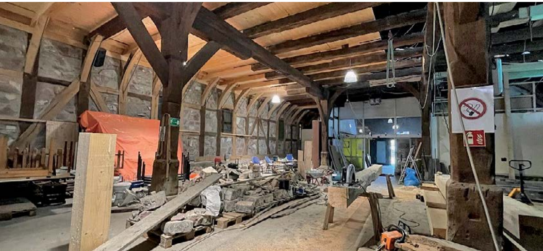
Sanierungsstand November 2022: Erneuerte Balkenkonstruktion auf linker Gebäudeseite.
