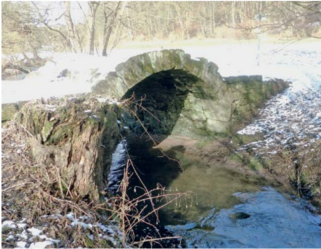
Die ‚Kurfürstenbrücke‘ über die Ems.
