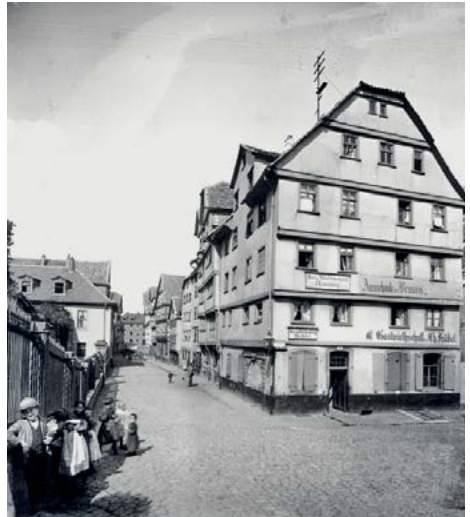
Ein Standortvergleich zwischen 1920 und 2022 – 1920: Blick vom Holzmarkt in die Mühlengasse auf das Haus der Gastwirtschaft Hübel, links der Staketenzaun am ‚Kastell‘ (heute Haus der Jugend).
