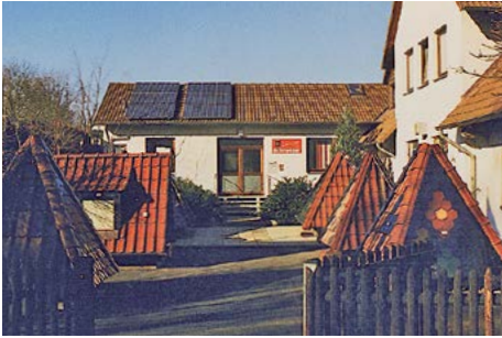
Bürogebäude der Fa. Schneider in der Buttlarstraße. Foto: Fa. Schneider
