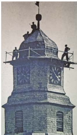
1950: Dachdeckerarbeiten am Turm der Marienkirche.
