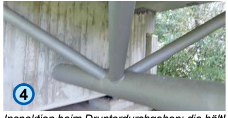
Inspektion beim Drunterdurchgehen: die hält!
