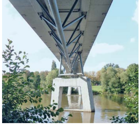
... zur Gärtnerplatzbrücke aus Spezialbeton.
